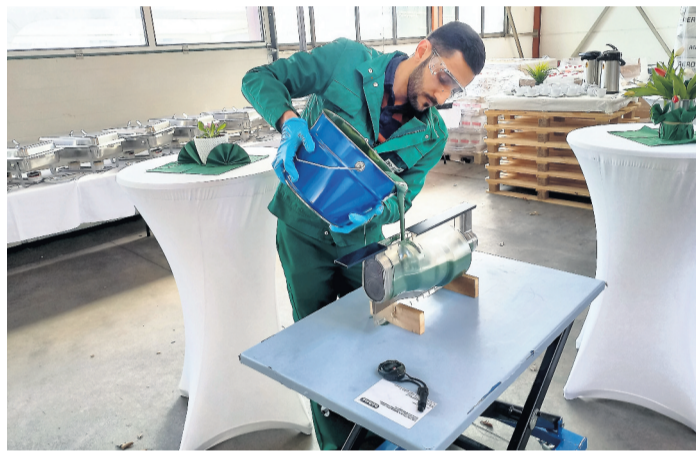
Ahmed Wali-Agha füllt die Kabelmuffe mit Gießharz, das anschließend noch einige Zeit zum Austrocknen benötigt.
