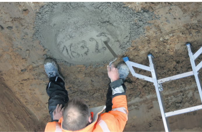
Polier Michael Vache schreibt das Datum der Grundsteinlegung in den Beton, unter dem die Kabelmuffe liegt.
